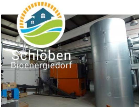
Der 20 kW ORC-Prototyp wurde im Bioenergiedorf Schlöben unter Realbedingungen gefahren. Wärmequelle war ein Holzhackschnitzelkessel, der für die Nahwärmeversorgung genutzt wird.
